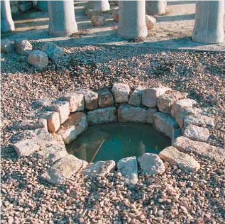
Mit dem Pumpensumpf an der tiefsten Stelle kann der Teich, falls nötig, leerpumpen werden.
