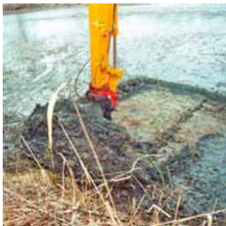
Um die Dicke der abgelagerten Sedimentschicht erfassen zu können, werden Beobachtungsgruben angelegt.
