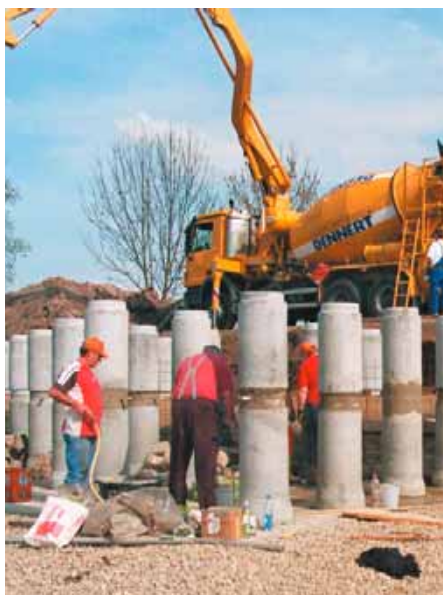
Auf die Viereisenspiralen werden 72 Standard-Betonrohre aufgesetzt und mit Beton vergossen.
