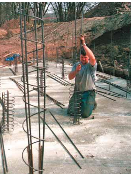
Die Viereisen der Bodenplatte werden mit Spiraleisen zur Aufnahme der Pfeilerkonstruktion verbunden.
