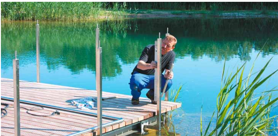
Abschließend werden noch Geländerstützen montiert, um den geltenden Vorschriften zur Absturzsicherung auf Badestegen zu genügen.
