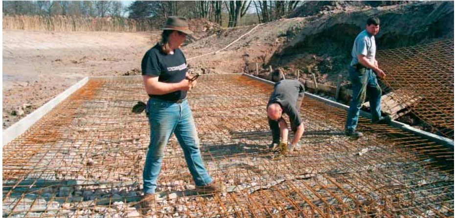
Als Unterbau für den Steg wird eine Schalung für eine Bodenplatte mit Betonkantsteinen gebaut, in der Bewehrungsmatten installiert werden.
