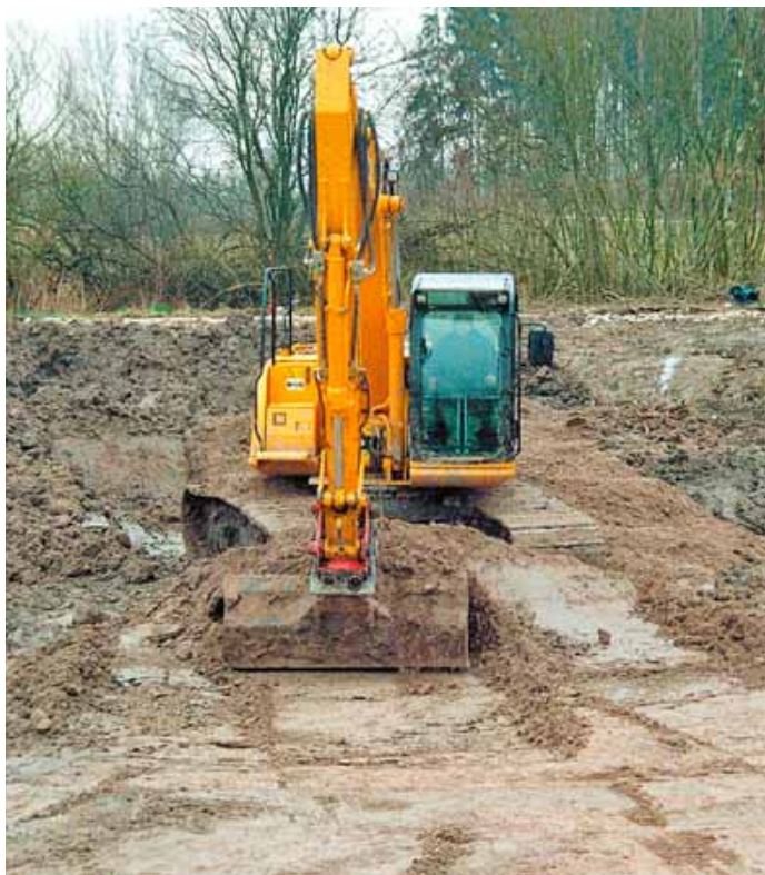
Um die Maximaltiefe des Naturbadesees von drei Metern zu erreichen, werden insgesamt rund 3.350 Kubikmeter Schlamm und Sand ausgebaggert.
