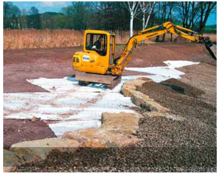
Mit Muschelkalkquadern wird der Schwimmbereich vom Sandstrand abgetrennt.
