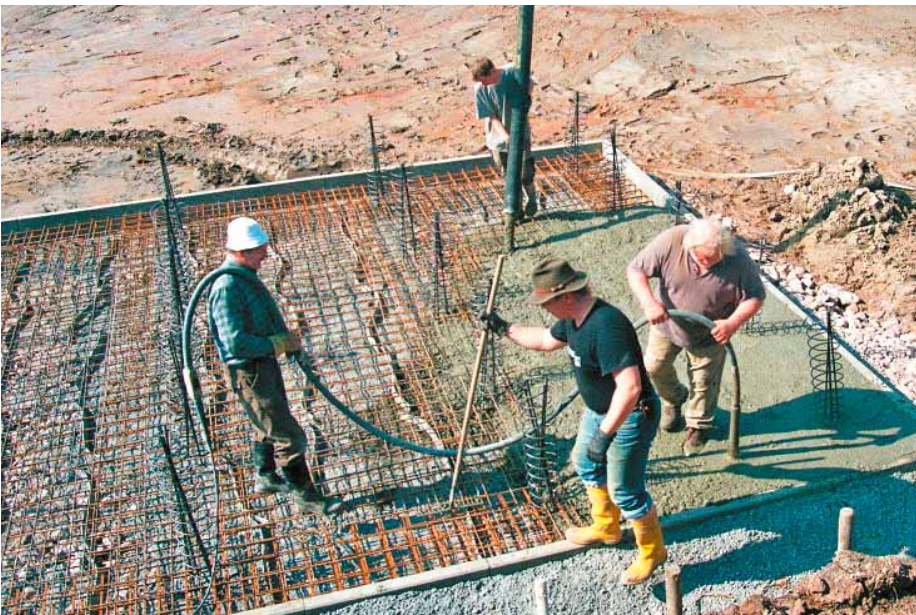
Die 30 cm dicke Bodenplatte für die Stegkonstruktion wird mit Ortbeton aus dem Betonmischer gefüllt.
